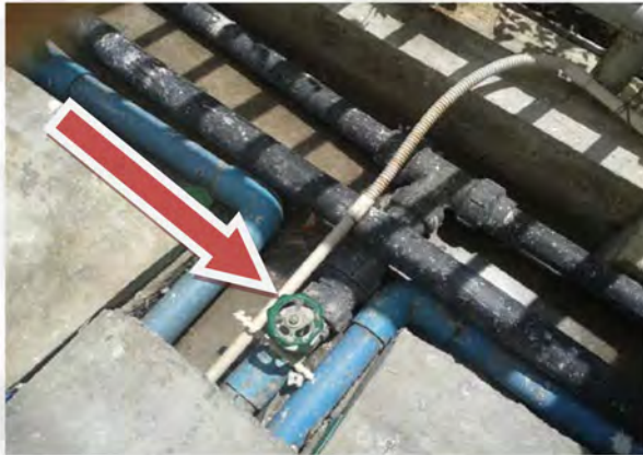
วาล์วน้ำประปาควบคุมน้ำในห้องน้ำโรงอาหารอยู่ด้านหลังโรงอาหารใกล้บ่อดักไขมัน
