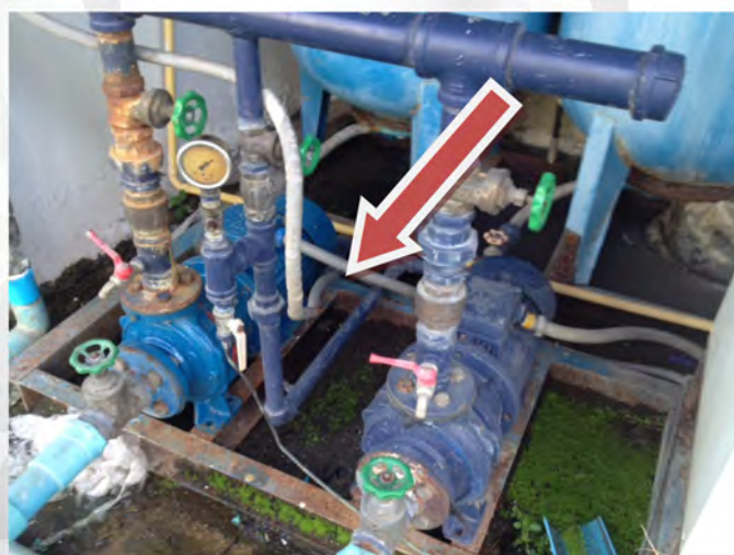
P9 บั้มสูบน้ำไปจ่ายหอพักนักเรียนหญิง 7 และอาคารรับรอง 11 อยู่บริเวณด้านหลังหอพักนักเรียนหญิง 7 ระบบทำงานด้วยบั้ม 2 ตัวและมีถังแรงดัน 2 ถัง
