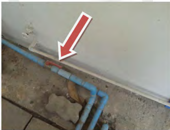
วาล์วน้ำประปาควบคุมน้ำในห้องน้ำโรงอาหารอยู่ด้านหลังโรงอาหารใกล้บ่อดักไขมัน
