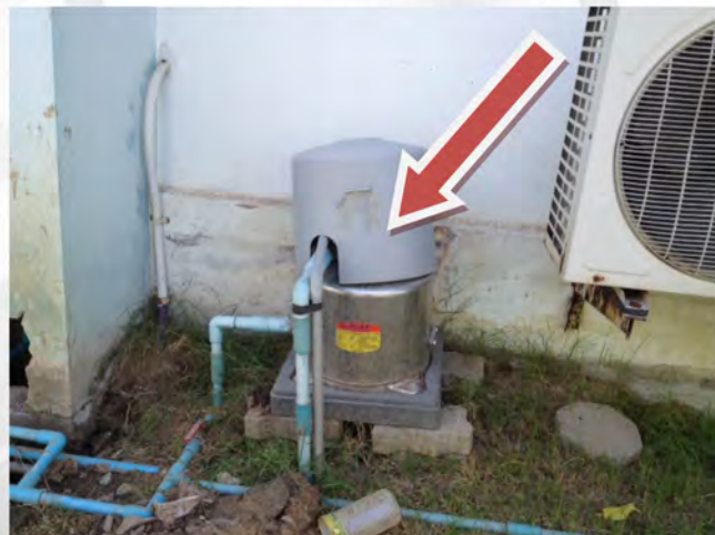
P9 บั้มสูบน้ำไปจ่ายหอพักนักเรียนหญิง 7 และอาคารรับรอง 11 อยู่บริเวณด้านหลังหอพักนักเรียนหญิง 7 ระบบทำงานด้วยบั้ม 2 ตัวและมีถังแรงดัน 2 ถัง
